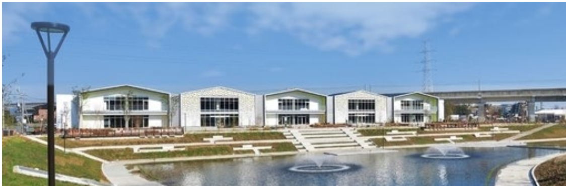
調整池のイメージ（池底を掘り込み常時水面を整備） （出典：柏の葉イノベーションキャンパス「アクアテラス」）
